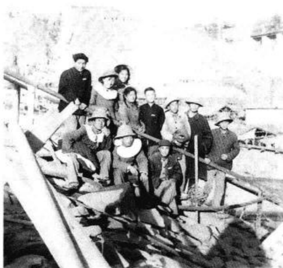
▲ 在三门峡大坝工地
