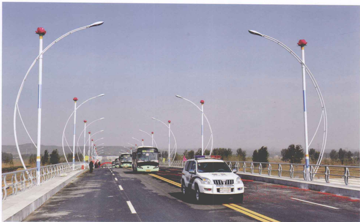
黄河同力大桥
