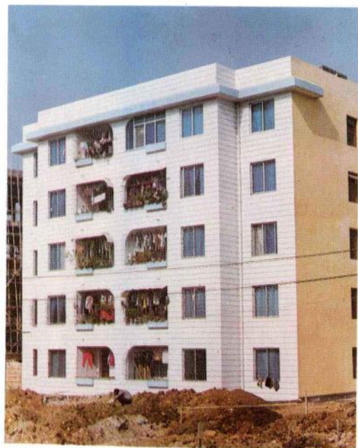
▲ 新建成的县土地局宿舍楼
