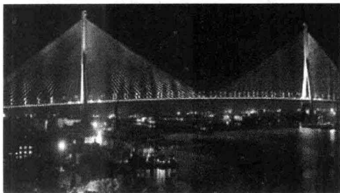
图 1.13 上海杨浦大桥
