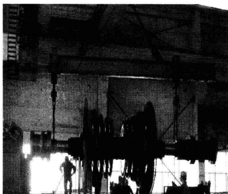
吊装汽轮机转子
