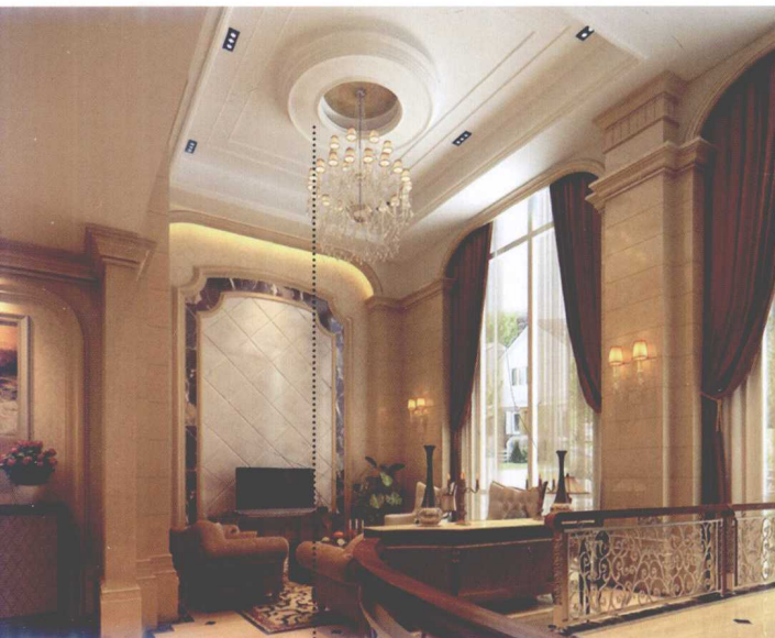
石膏板异型吊顶
