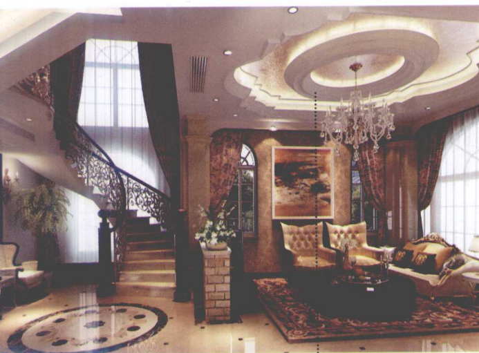
石膏板异型吊顶
