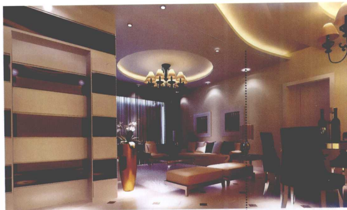
石膏板异型吊顶
