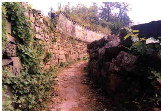
羊场镇镇旗屯古城墙，建于明代。
