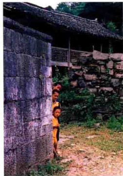
江古乡小坪古城墙，长200米，高3米，始建于明代，是苗疆长城的组成部分。
