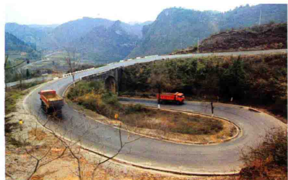
螺蛳桥，位于镇远、施秉两县交界处，1937年建成。其地名称“鹅翅膀”，为历代屯兵的重要关隘。
