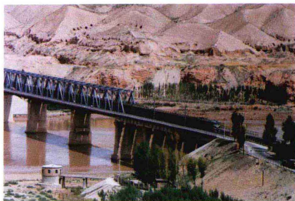
红嘴子黄河铁、公路两用大桥
