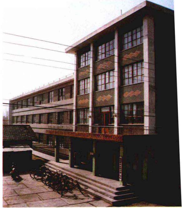
靖远县农技中心大楼
