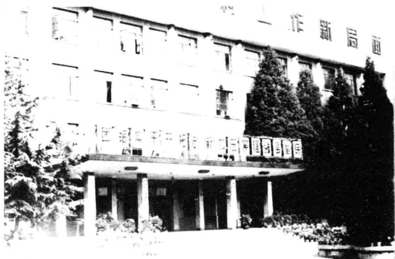
县总工会办公地址(县委办公楼三楼)
