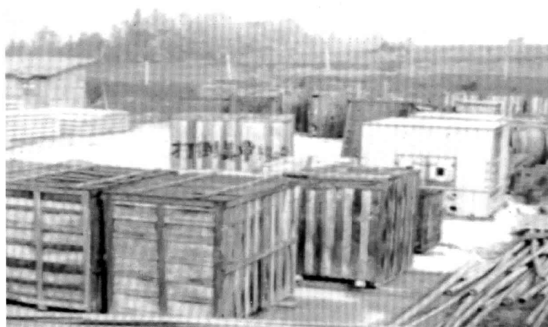
源源不断地运到工地的建设物资
