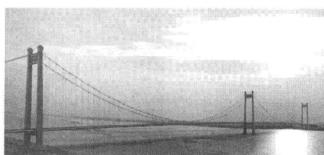
b)马鞍山长江公路大桥
