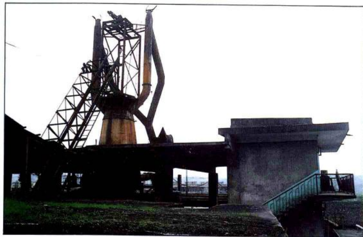
州工程公司设计施工的州泸溪磷肥厂
