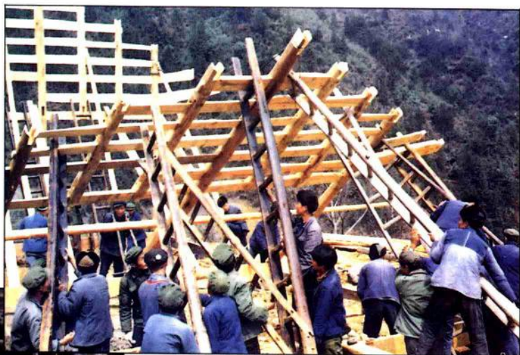
▲ 民间建房竖排架
