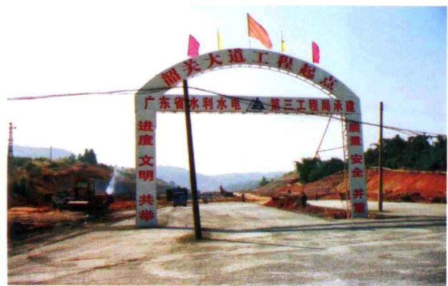
正在兴建中的韶关大道
