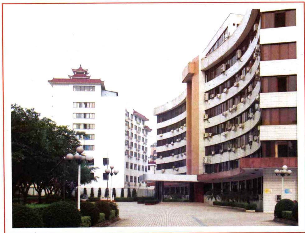
区机关办公楼
