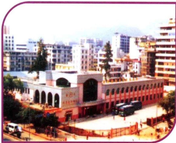
韶关西河客运站
