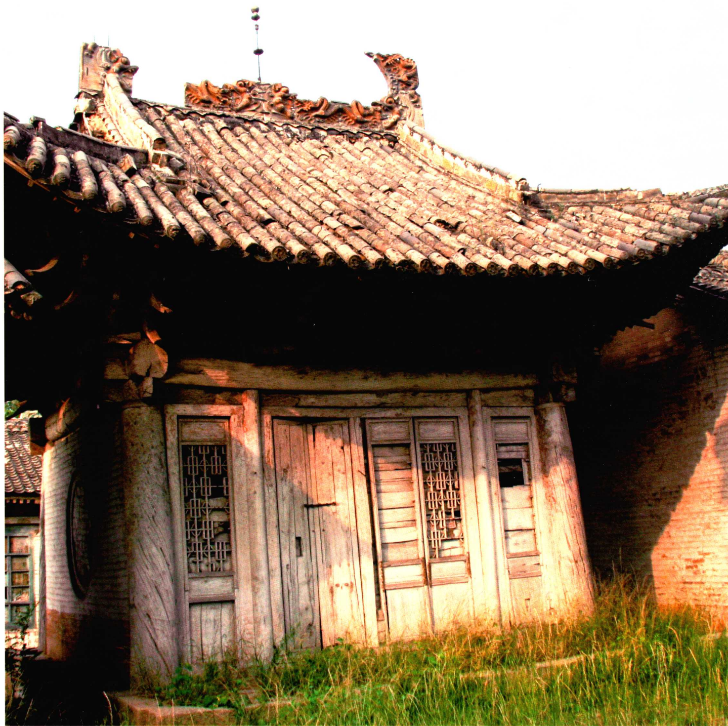
炎帝中庙无梁殿
