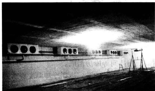
图 1-7 正在建设中的大型蔬菜储存冷库
