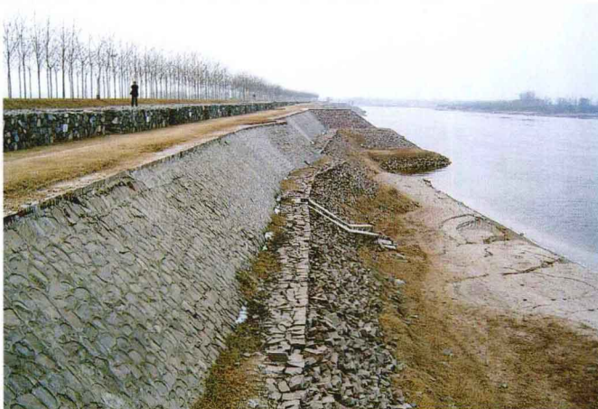
黄河孟津段河道整治工程——护岸石坝
