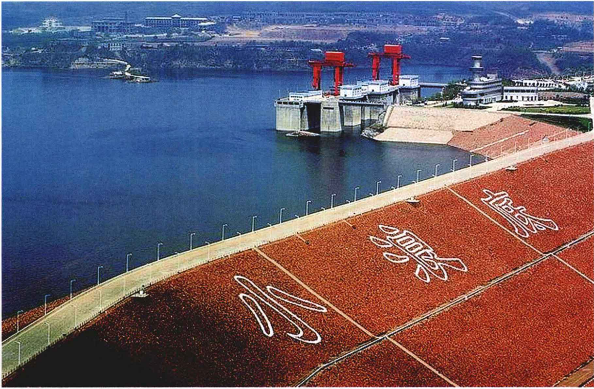
黄河小浪底水利枢纽工程
