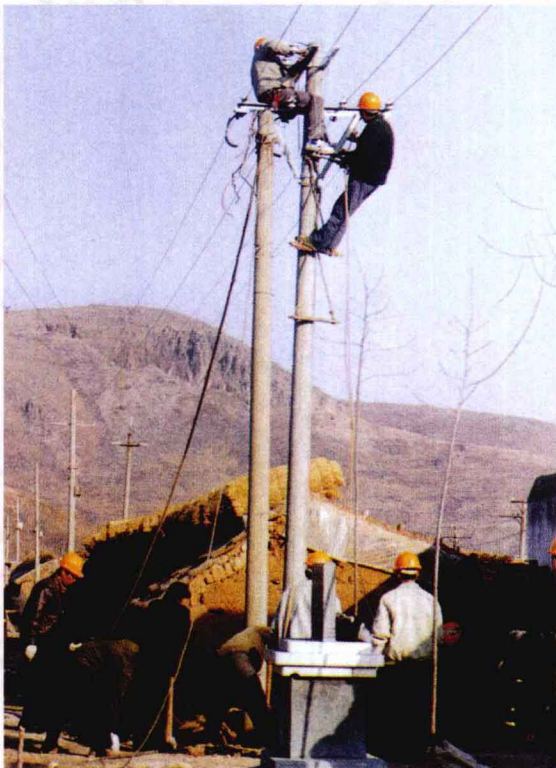
农网改造施工现场一角
