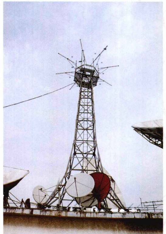
无线电固定监测站铁塔
