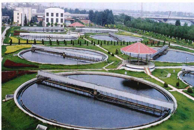
日处理污水 20 万立方米的涧西污水处理厂
