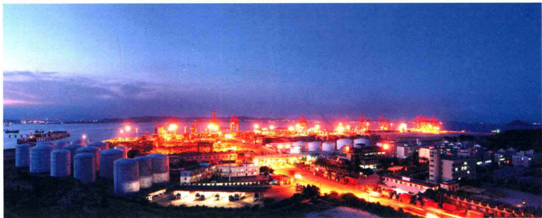
泉州港石湖作业区集装箱码头
