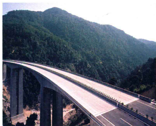
福银线福州至三明高速公路猫坑溪特大桥
