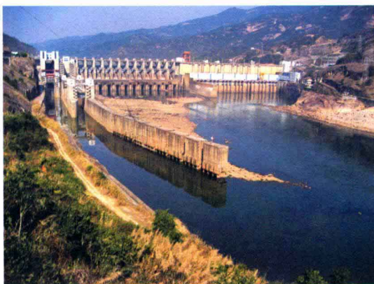
水口水电站坝下过坝船闸、升船机和引航道
