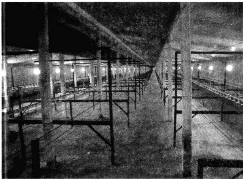
图 1.2 网上饲养建设中的鸡舍
