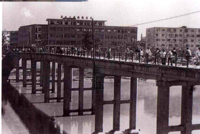
周口大桥（1935年建）
