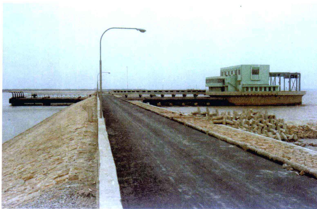
宝山湖水库取水泵房外景。
