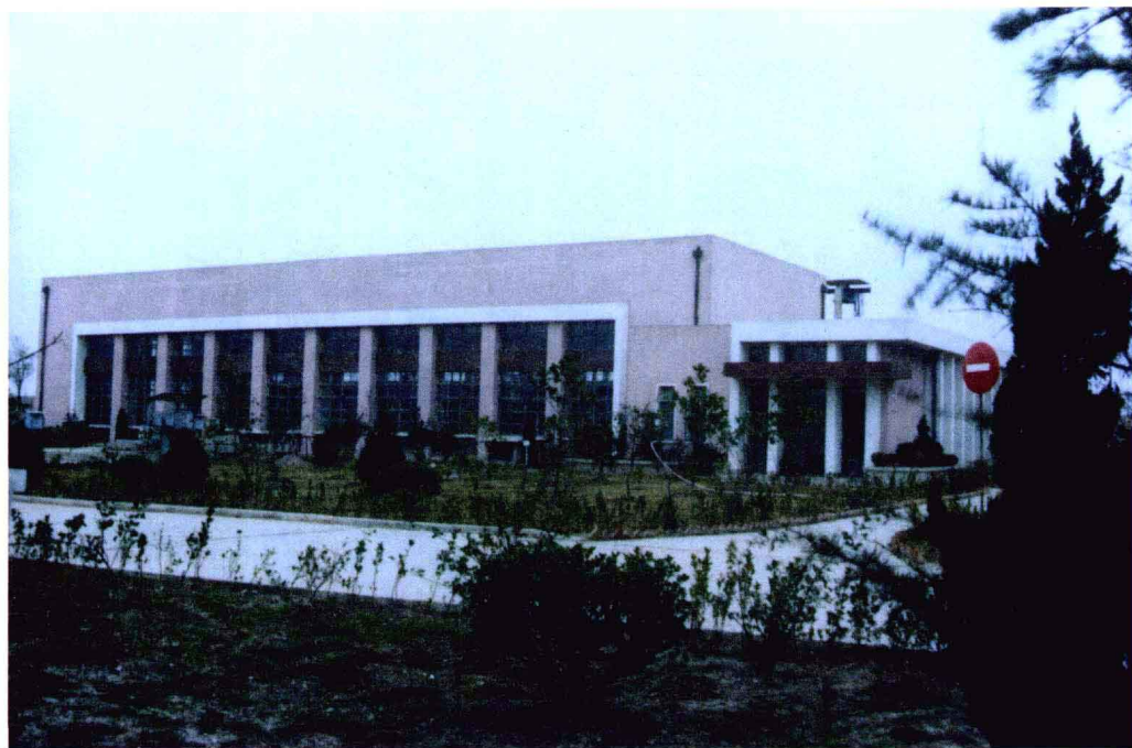
宝山湖水库输水泵房外景。
