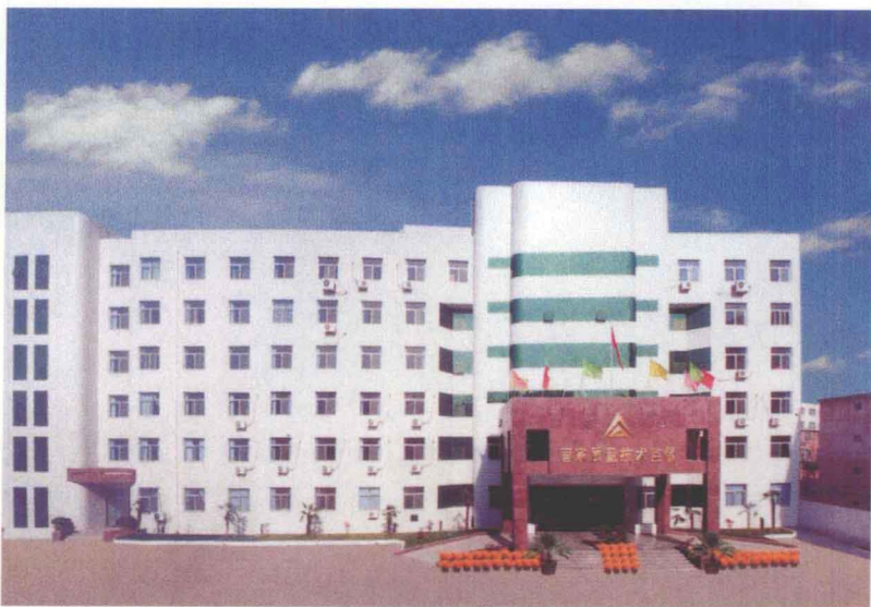
综合检测大楼
