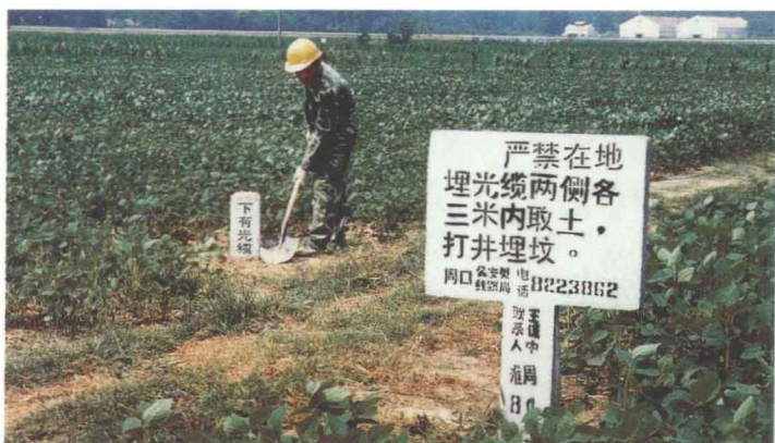
线路维护人员作业现场
