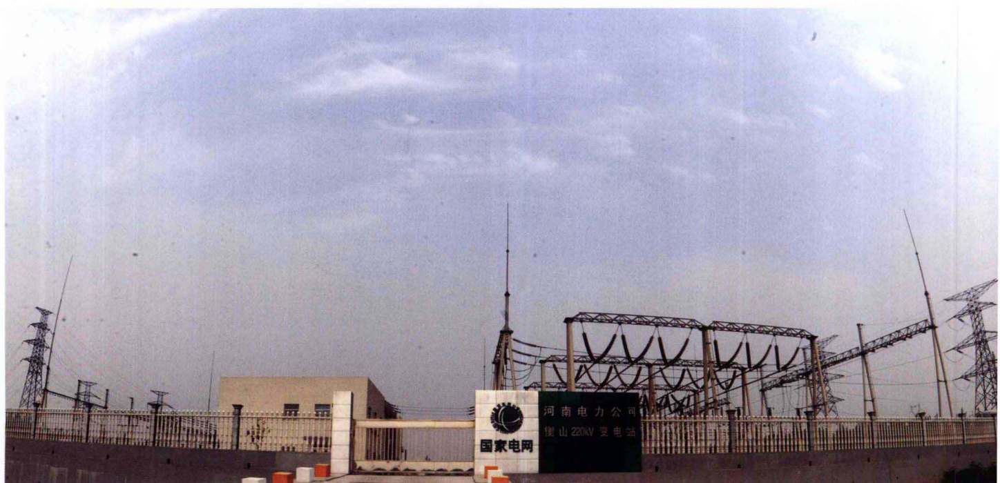
衡山 220 千伏变电站（2008 年 12 月投运）
