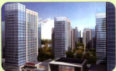
北京亦庄林肯公园 II 期 地源热泵工程
