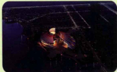
保定市关汉卿大剧院和博物馆 地源热泵系统工程
