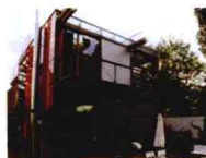
266 太阳能箱式住宅
