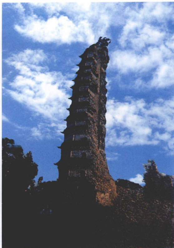
半壁坍塌的法门寺明代真身宝塔
