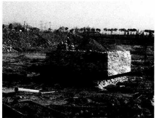
图 1.5 单桩承载力现场加载试验
