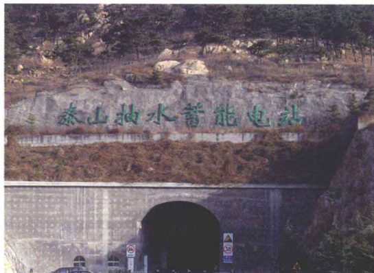
山东鲁能商贸有限公司贵和物业管理分公司项目之泰山抽水蓄能电站
