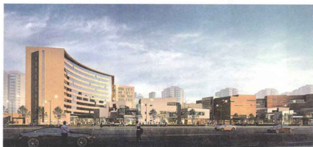
上海中星集团申城物业有限公司三林城市商业广场项目
