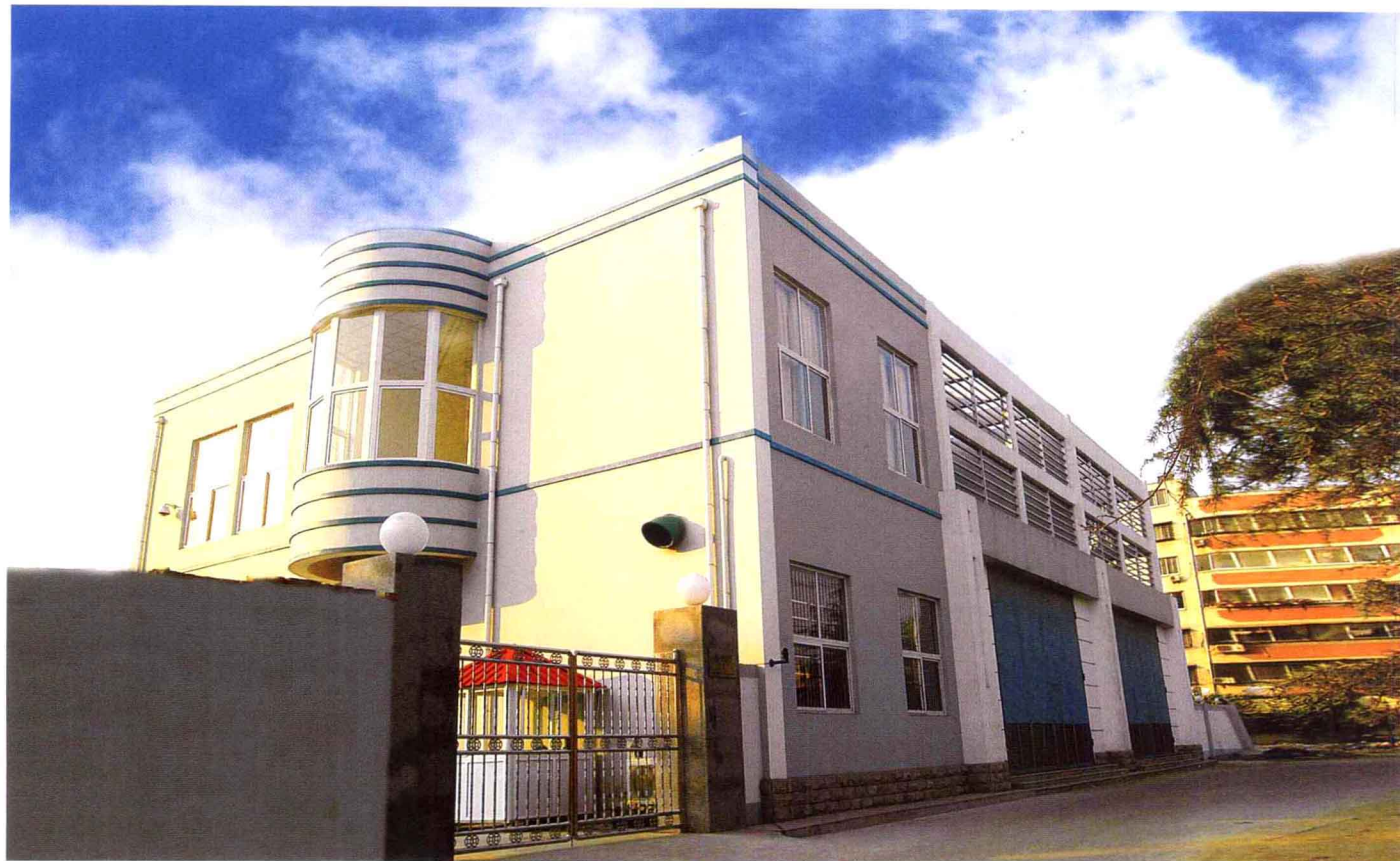
110千伏中心变电站（2008年6月投运）
