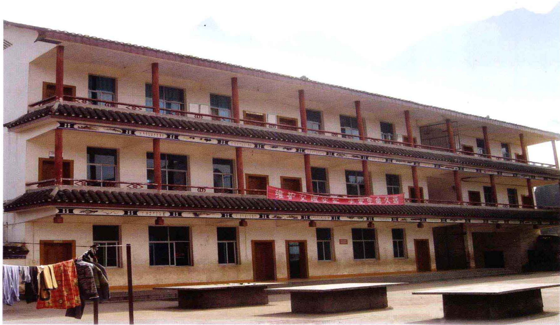
大理援建的芙蓉桥乡白族小学教学楼
