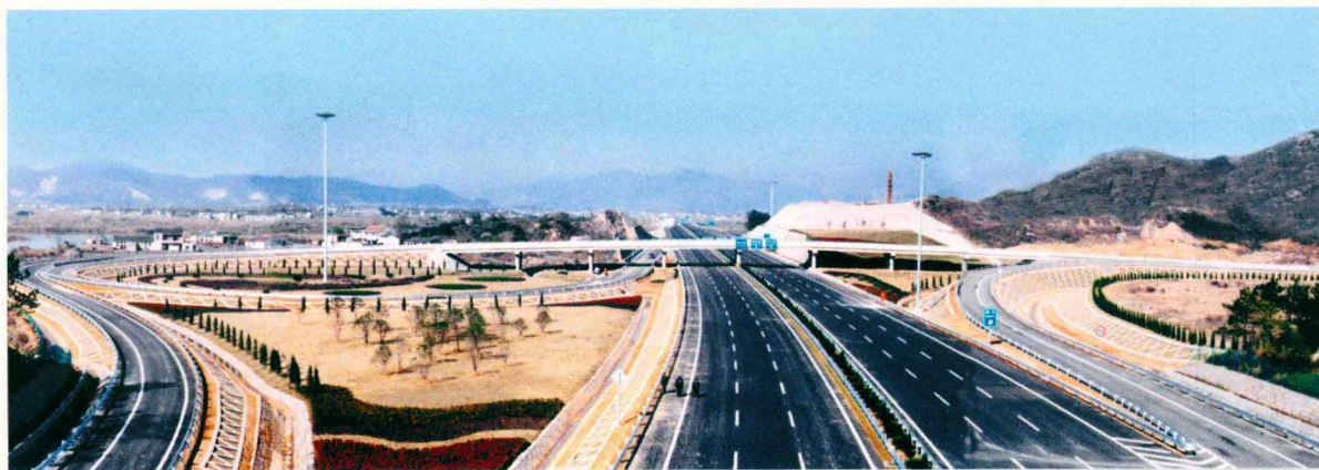
大力支持基础设施建设。图为中国 工商银行浙江省分行贷款7亿元支持的 杭宁高速公路一期工程鹿山交通区全 景。（下图）
