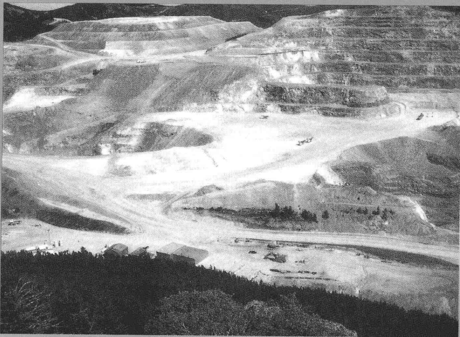
【圖四】蒙大拿的佐特曼—藍達斯基礦場，現已廢棄。這是美國第一座設有巨大氰化物堆浸場的礦場，利用劇毒的氰化物來溶解礦石中的微量黃金。
