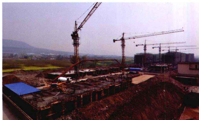
城中村改造施工现场
