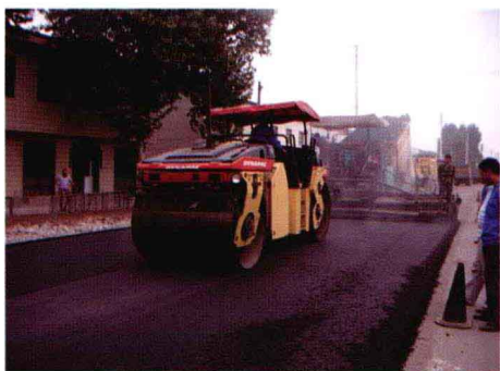
道路碾压施工现场
