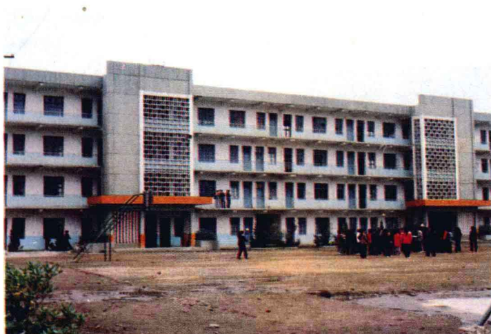
荆门市职业技术教育中心教学大楼
