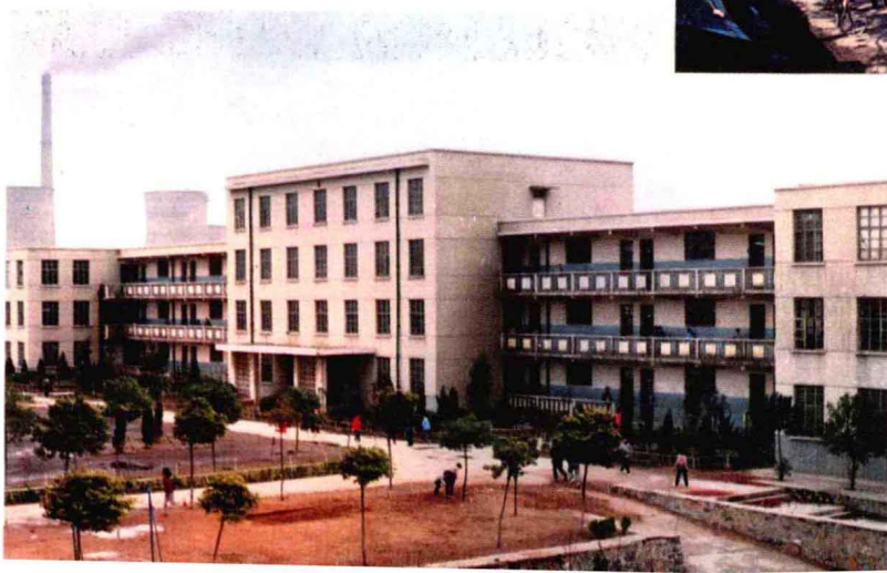
荆门炼油厂第一中学教学大楼
