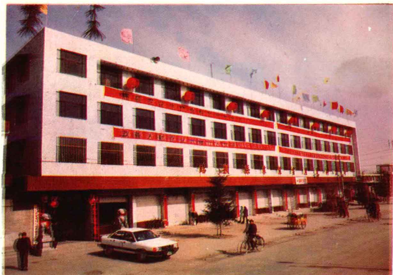
县农资公司办公大楼
