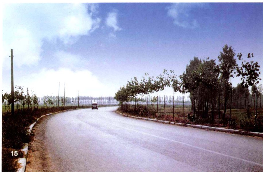
开洛高速公路中牟至贺岗连接线
