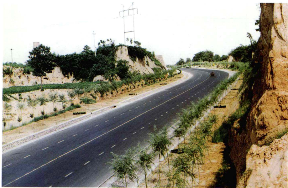
改建后的国道 310 线荣阳路段
