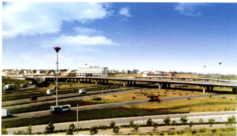
国道107线南三环立交桥
