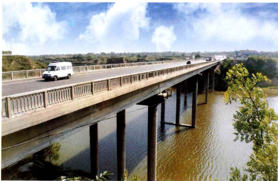
豫 03 线侯寨大桥
