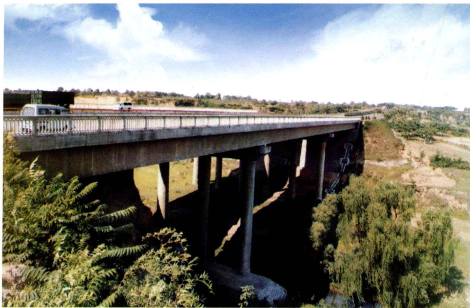
绕城高等级公路贾鲁河大桥
