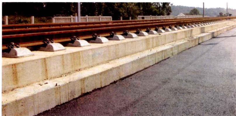
图 1-4 双块式无砟轨道结构组成
