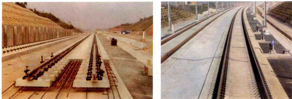
图 1-3 双块式无砟轨道结构
