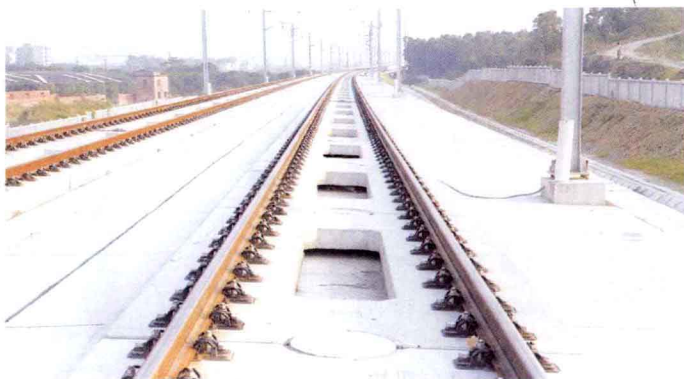
图 1-6 单元板式无砟轨道结构
