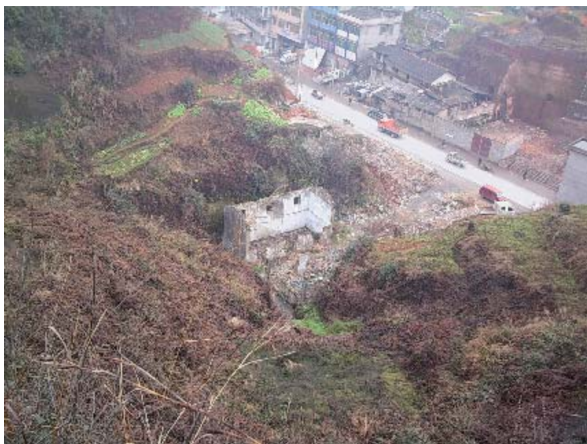
图1-1 临近道路现状
