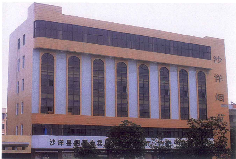
■ 沙洋烟草公司综合楼（摄于2002年）
