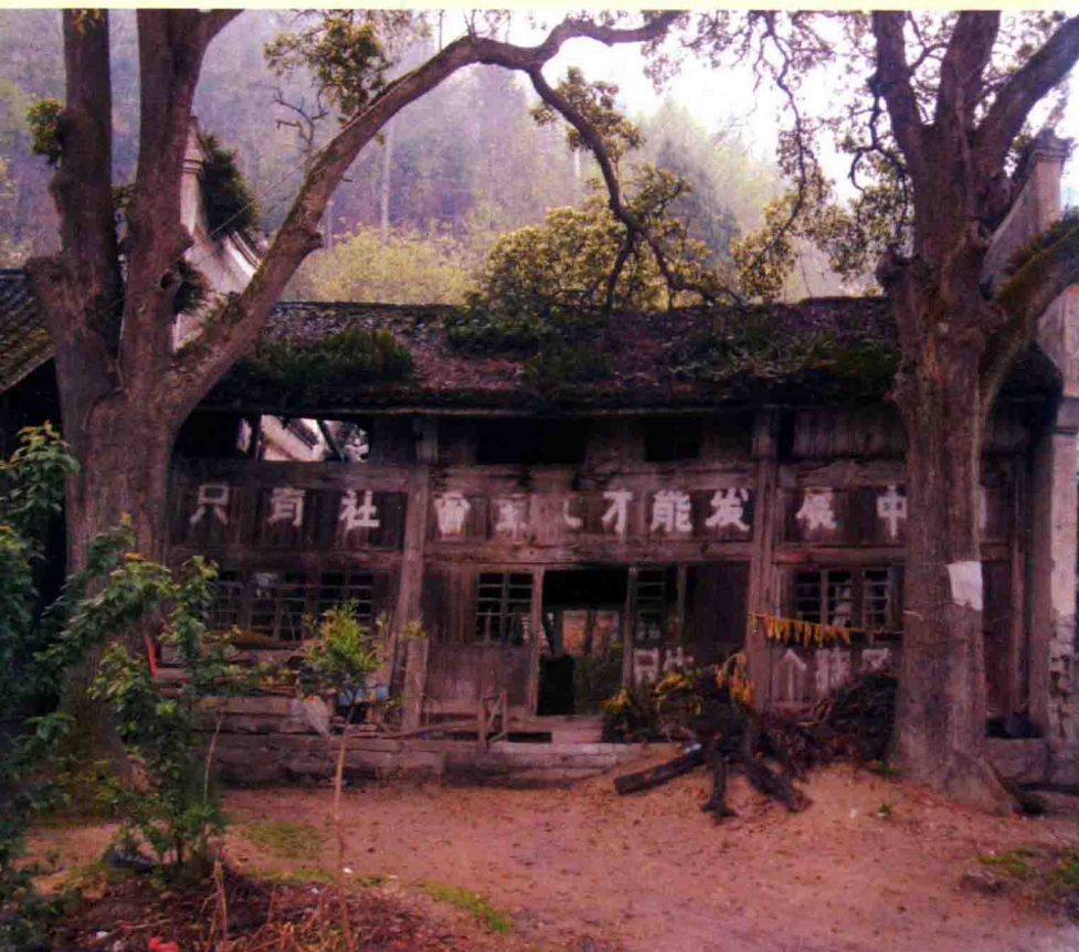
江西街小学（2010年初已坍塌）
