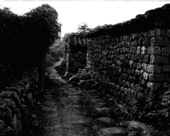
南轩村古村落的火山石房子
