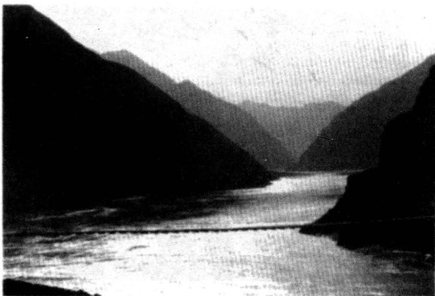
黄河甘、宁交界处“小观音”段吊桥，是西北电力勘测设计院为勘测此地段地质构造而架设的。
