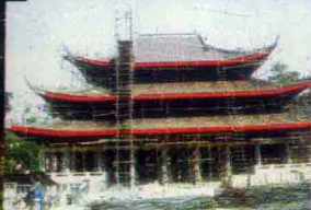
正在维修的三宝寺
