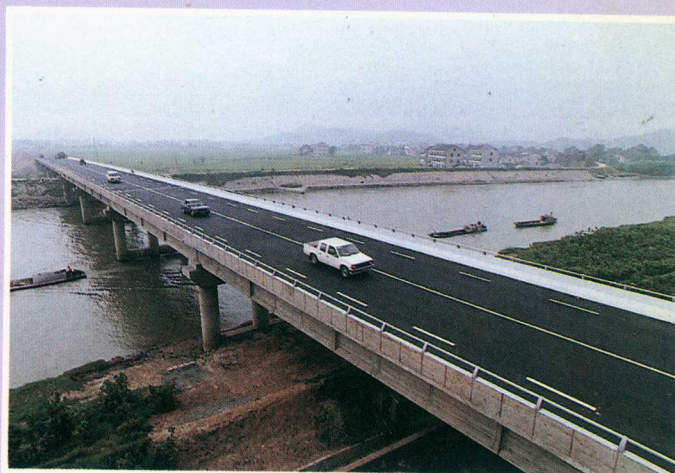
我省交通堵塞四大“瓶颈”之一的萧山临浦，建成新的大桥，昔日“瓶颈”已成坦途。
