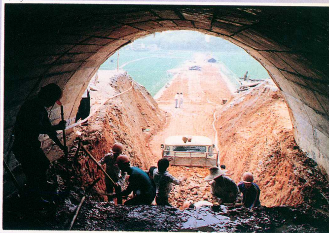
我省“重中之重”建设项目的金温铁路正在紧张施工中。
