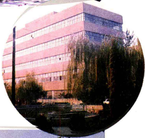
位于中原西路 教学实习楼
