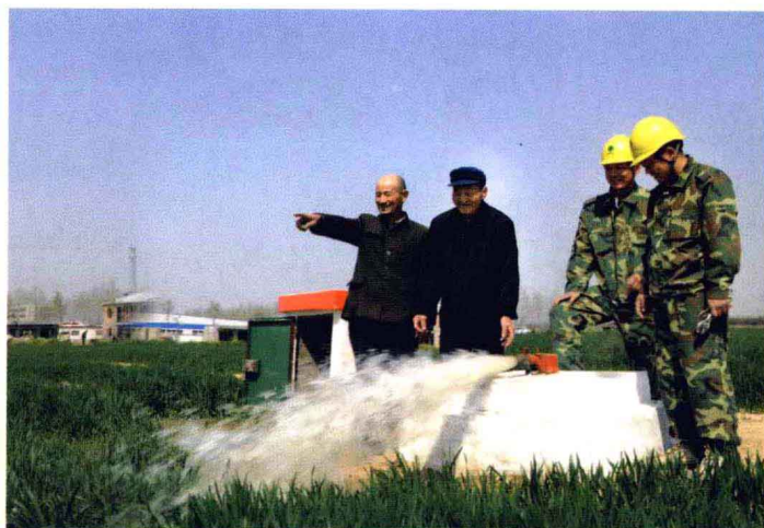
2008年，周口供电公司深入推进“农田机井通电示范工程”，新建124个台区，原来使用柴油机带动抽水泵的2543眼机井全部通电
