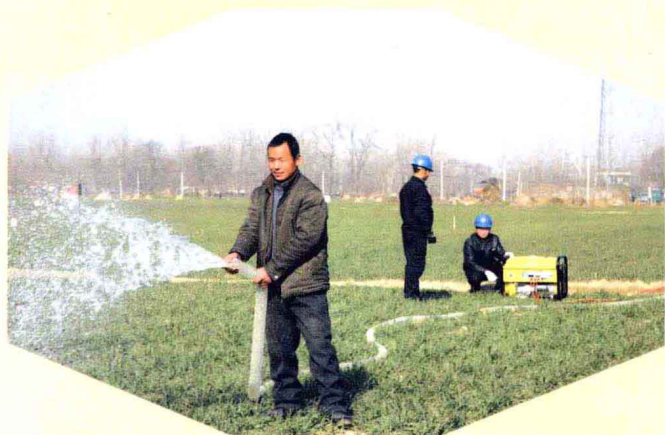
2009年初，周口遭遇50年一遇的大旱，周口供电公司迅速行动，通过发挥农田机井示范工程的作用、安装临时电源、调配发电机等措施，为农民抗旱提供电力支持。
