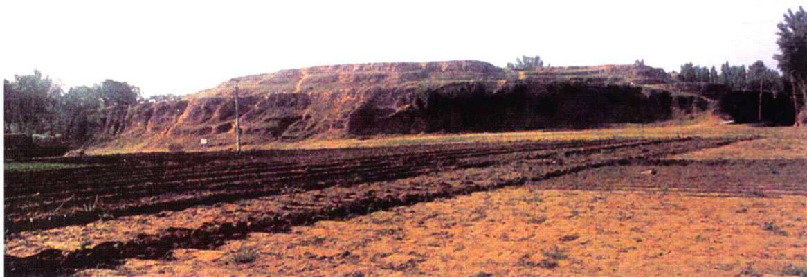
1. 易县燕下都武阳台宫殿建筑夯土台基（北→南）
