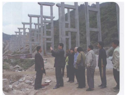
福银高速公路建设现场观测
