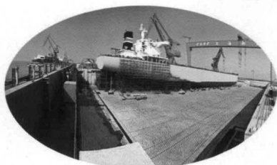
上海船厂船台工程
