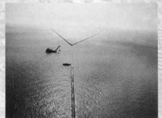
长江口深水航道治理工程分流口
