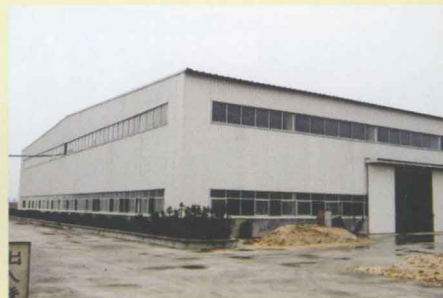
温泉工业规划区入驻企业建设中的宏达耐火材料厂生产车间
