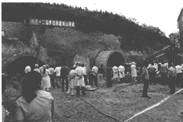
图 1.3 大连市在建南山隧道坍塌救援图
